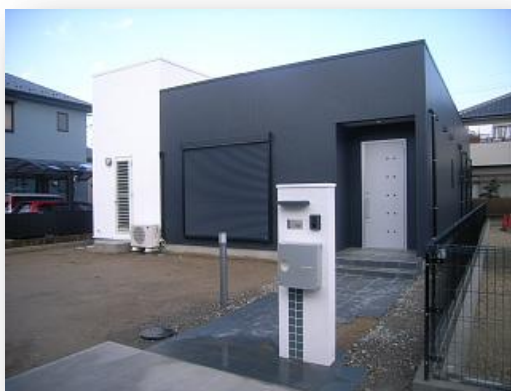
○ 邸新築工事 [現場担当] 尾張支店
