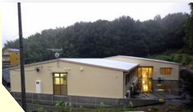
福祉施設 新築工事 [現場担当] 尾張支店
