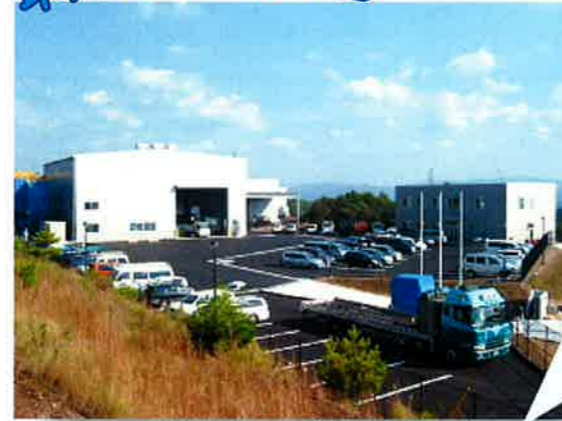
二明精機(株) 土岐工場新築工事 [現場担当] 大池 哲弘・林 研 [設計担当] 今井 清美・高橋 豊
