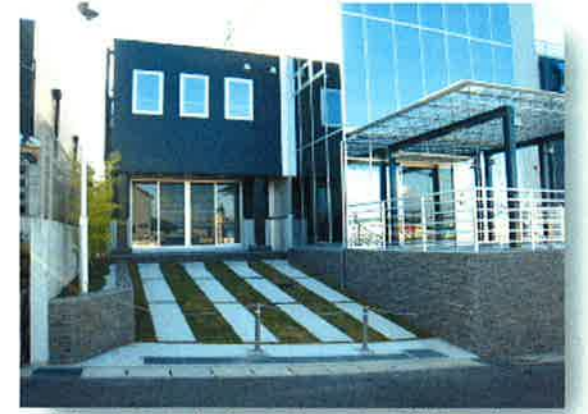
(株)イーエム大高 SE センター増築工事 [現場担当] 佐藤 鋭二・市原 晃広
