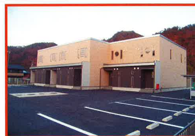
七宗町町営住宅 (仮称)コーポロックタウン新築工事 (工務担当)可児支店：林 数馬 美濃輪 敦
