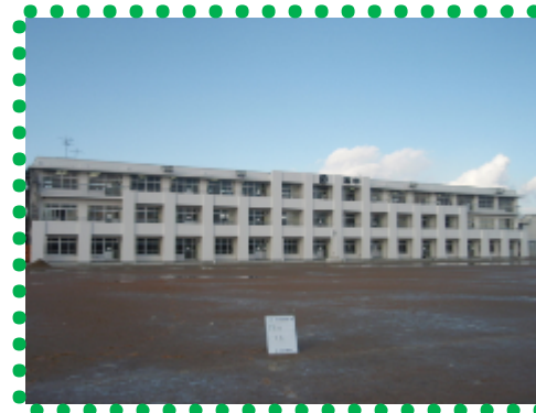
西中学校南舎耐震補強工事
