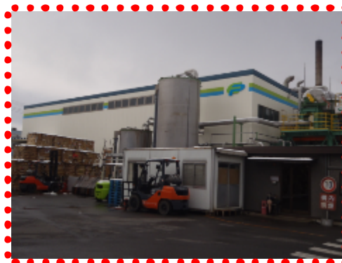
エコパーJP施設新築工事
