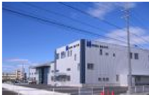
(株)ヨシミツ 事務所・工場新築 (工務)佐藤 鋭二・美濃輪 敦 (設計)今井 清美
