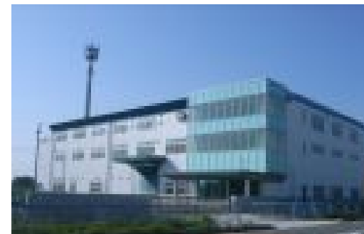
江南特殊産業株式会社大口工場新築 (工務)尾張支店 大池 哲弘
