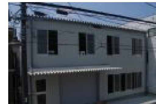
名古屋ショーケース(株)倉庫新築 (工務)曾根 功至・杉岡 昌明
